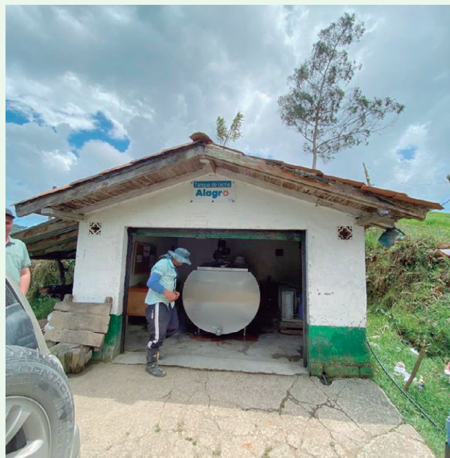
Tanque comunitario de enfriamiento de leche Municipio de Abejorral – Vereda Combia. Autor: Cooperativa ALAGRO.
